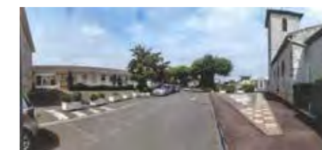
la rue du Levant avant travaux
